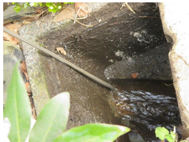
高圧洗浄で根を切り除去します。
